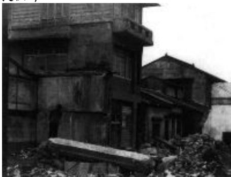
新化鎮護國里三層樓之鋼筋混凝土建築物倒毀(1946.12.23 攝，陳培源教授提供)
