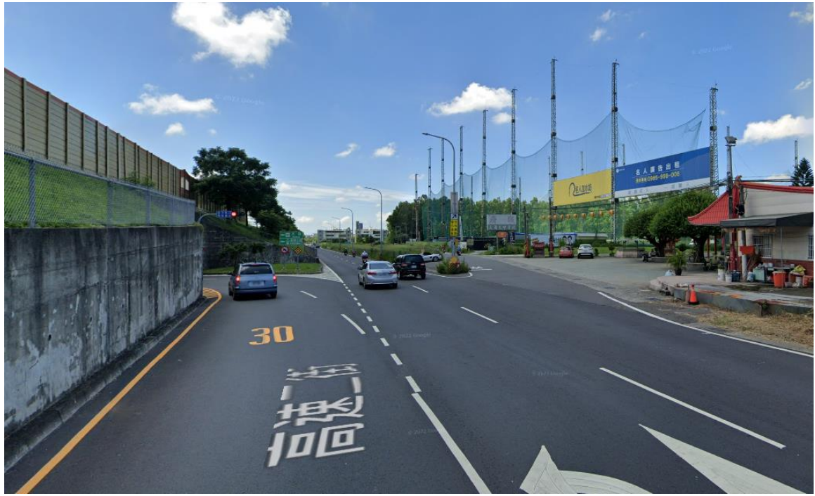
圖 10 迴轉道增加為 2 車道現況照片
