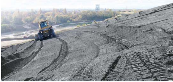
掩埋場工程施工
