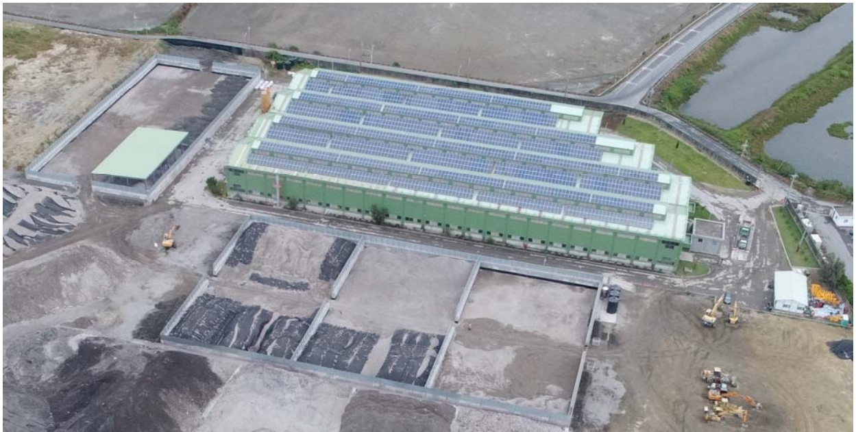
A. 廠區現況照片
