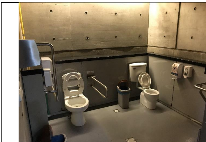
名稱：國立臺灣歷史博物館1樓親子廁 地址：臺南市安南區東和里長和路一段250號
