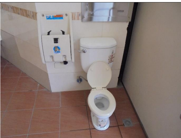
名稱：關廟服務區南下西側親子廁 地址：臺南市龍崎區楠坑里楠坑12之1號
