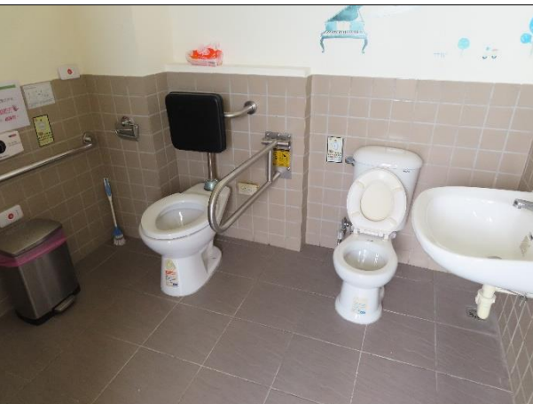
名稱：北門區圖書館 1F 親子廁 地址：臺南市北門區北門里港北 4 9 號
