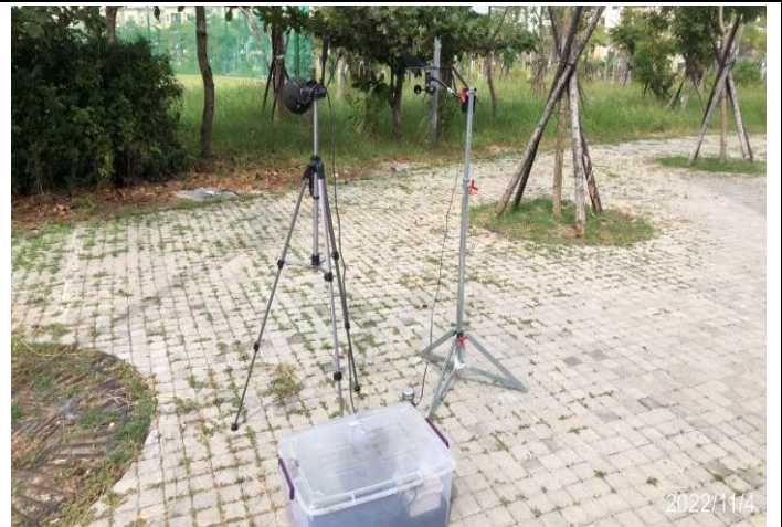
噪音振動(工區周界外 15 公尺-鄰近仁愛之家方向)
