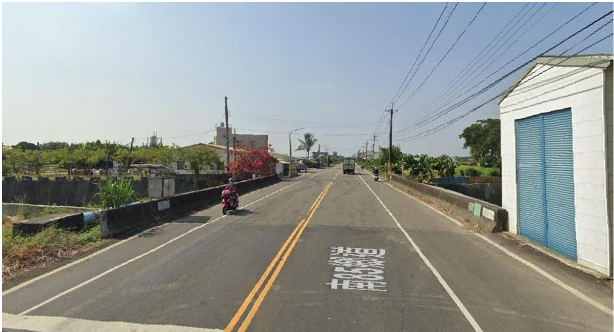
圖 23 南 85 軸線現況照片
