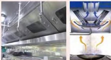
圖 3-3 水洗油煙罩示意圖
