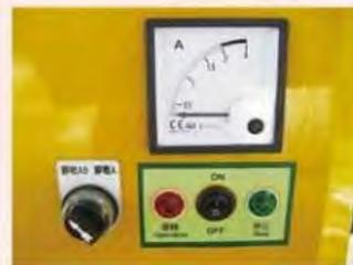
圖 3-9 靜電集塵器之設備使用電流儀錶
