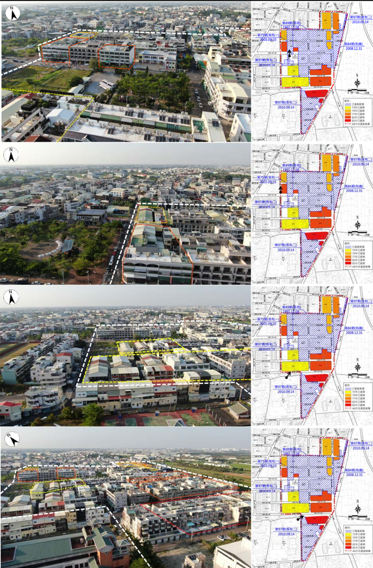
圖 4-4 建築歷程現況空拍照
