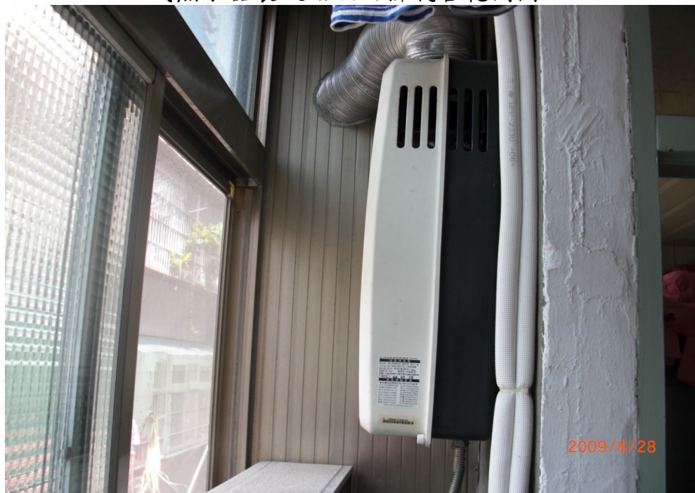
CF 式熱水器裝設錯誤之排氣管範例圖
