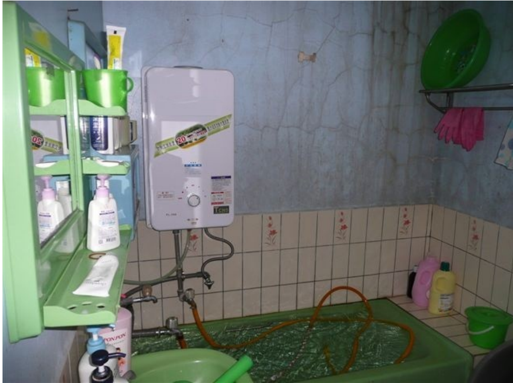
CF 式熱水器未裝設排氣管範例圖
