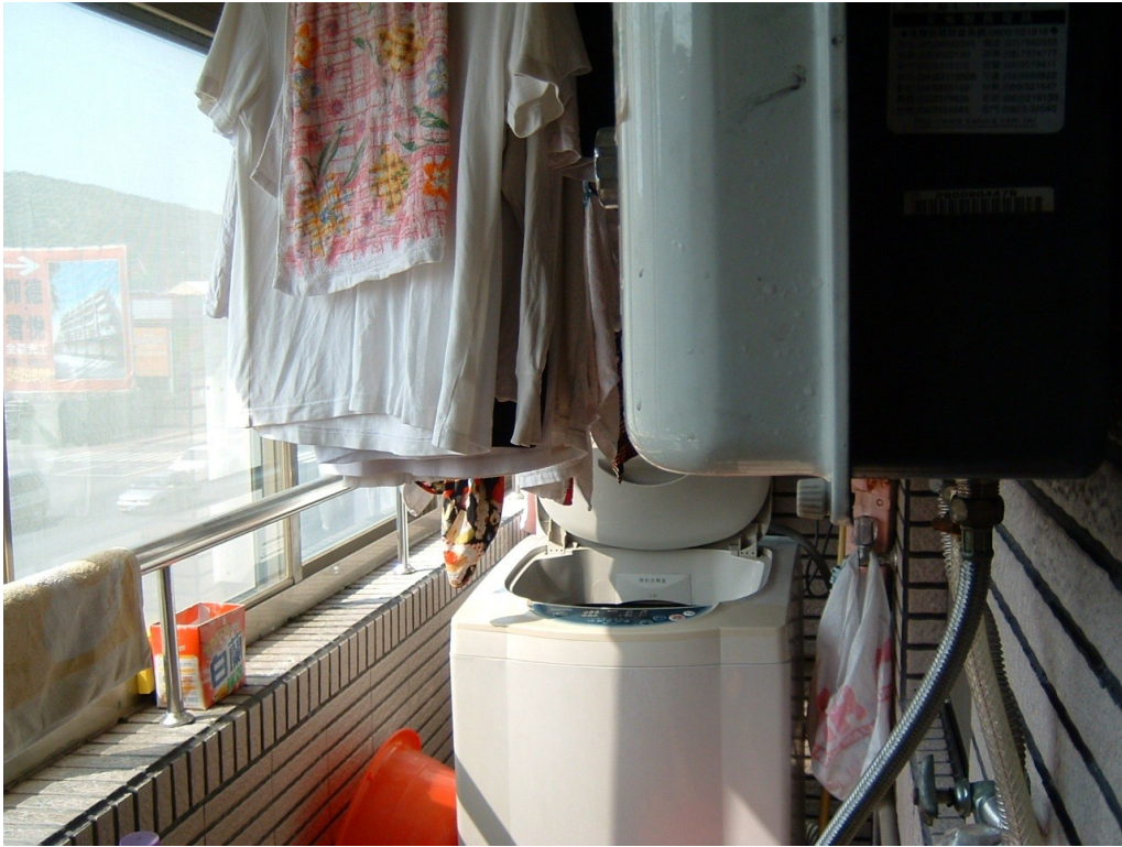
RF 式熱水器裝設於加蓋陽台範例圖
