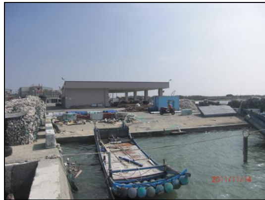
突堤西側之上架設施
