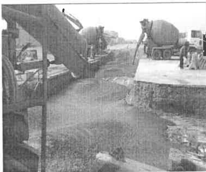
圖 4-7 工程案例一現地照片(灌漿中)
