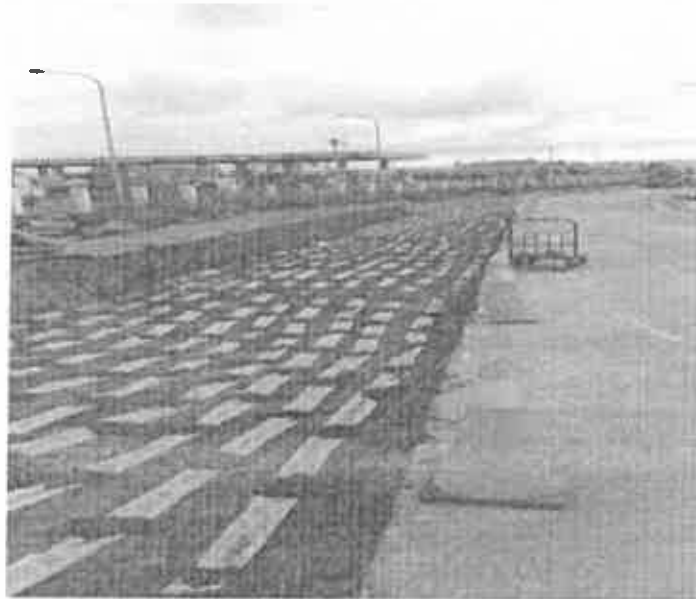
圖 4-6 工程案例一現地照片(環索前)
