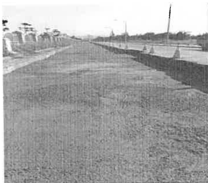
圖 4-8 工程案例一現地照片(灌漿後)
