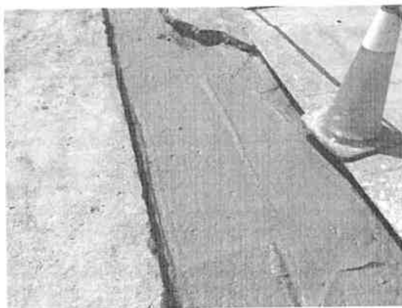
圖 4-13 工程案例三現地照片(灌漿後)
