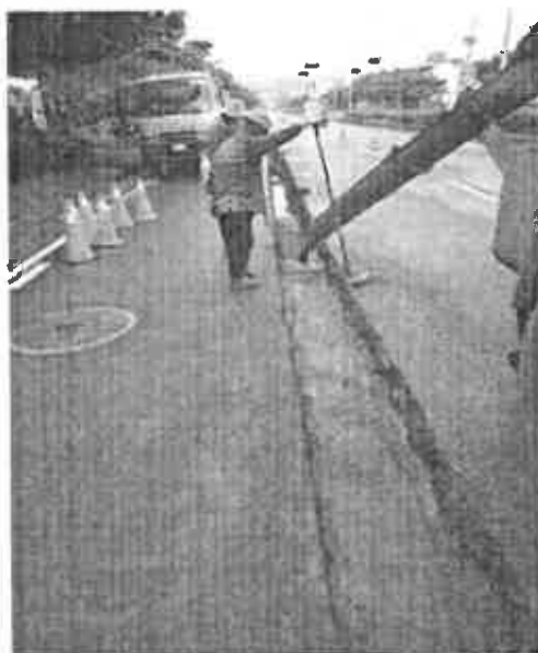
圖 4-10 工程案例二現地照片(瀝青中)
