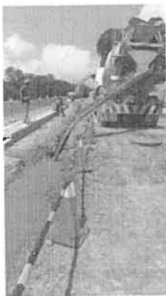
圖 4-12 工程案例三現地照片(灌漿中)
