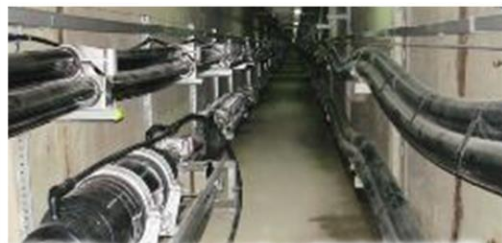
南科E/S 345kV電纜隧道
