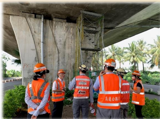
▲ 張副分局長領隊工程安衛稽核-112.10.27國10燕巢至國3林邊段光纜通道建置工程(110)
