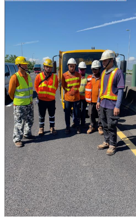
2024/09/10 09:22:17 120.401769 23.294415 白河段轄區瀝青混凝土路面整修及零星修補工程 (113)
