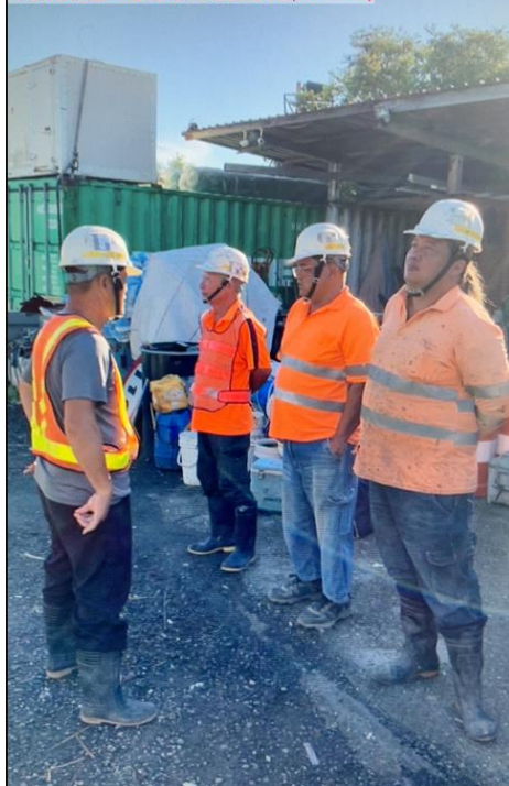
2024/09/10 07:47:30 120.401970 23.340115 新營段轄區一般結構物維護工程 (113-114)
