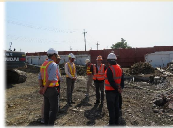
▲ 林副分局長領隊工程安衛稽核-112.11.13國道1號岡山交流道加油站新建工程(111)
