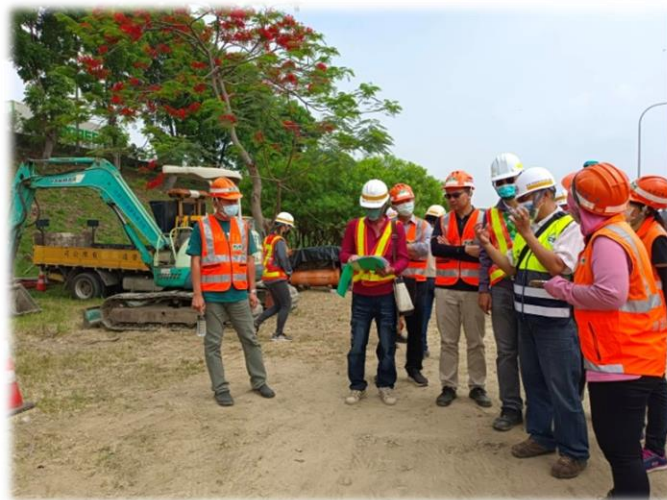
▲ 112.05.12安衛家族績效評選現場評核-國1安定交流道北出匝道改善工程
