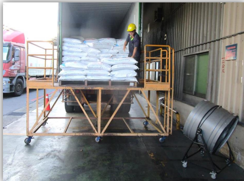
貨櫃卸貨作業增設移動式風扇
