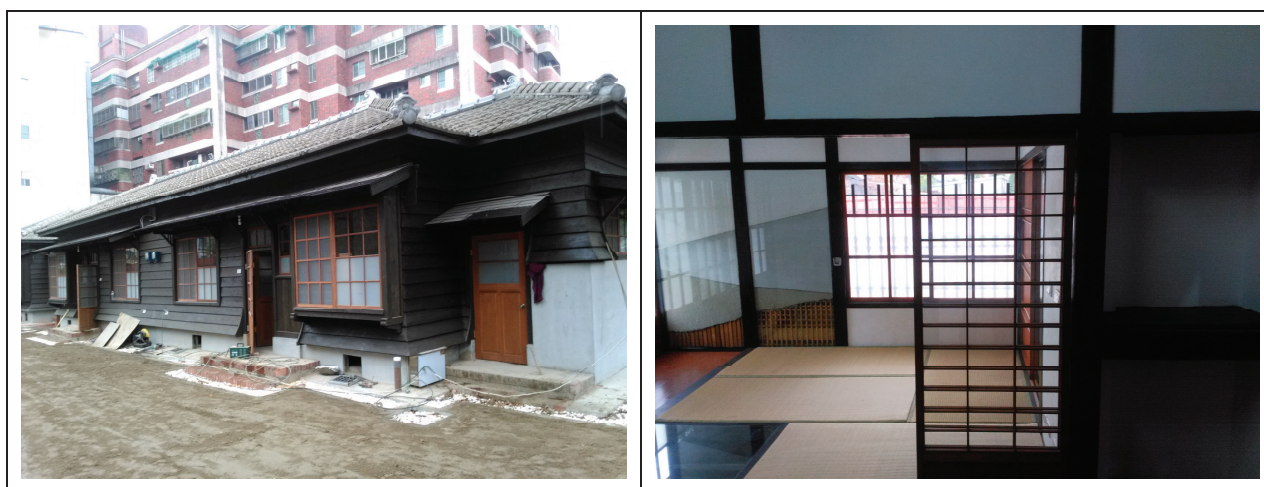
圖 3.1 修復完工照片
