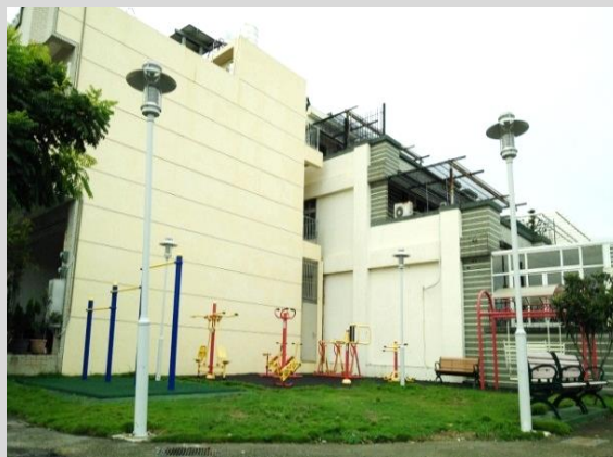
東昇街體健設施
