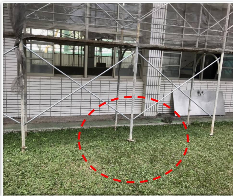
(C)左棟鷹架底座不宜放在土壤上，避免雨天鬆軟。【L】(5.14.99)
