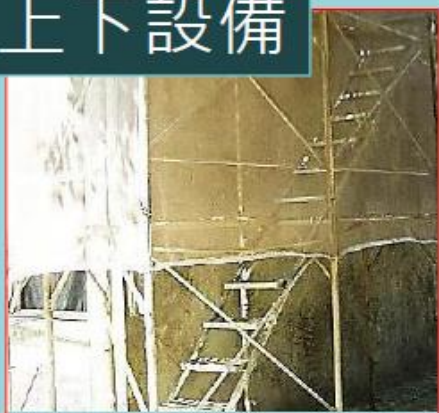
高差 \geq 1.5\text{m} 要設上下設備
