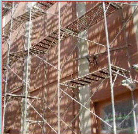
高差 \geq 2.0\text{m} 要設工作台
