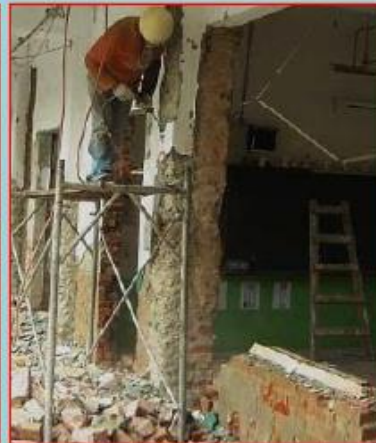
高差 \geq 2.0\text{m} 要設工作台
