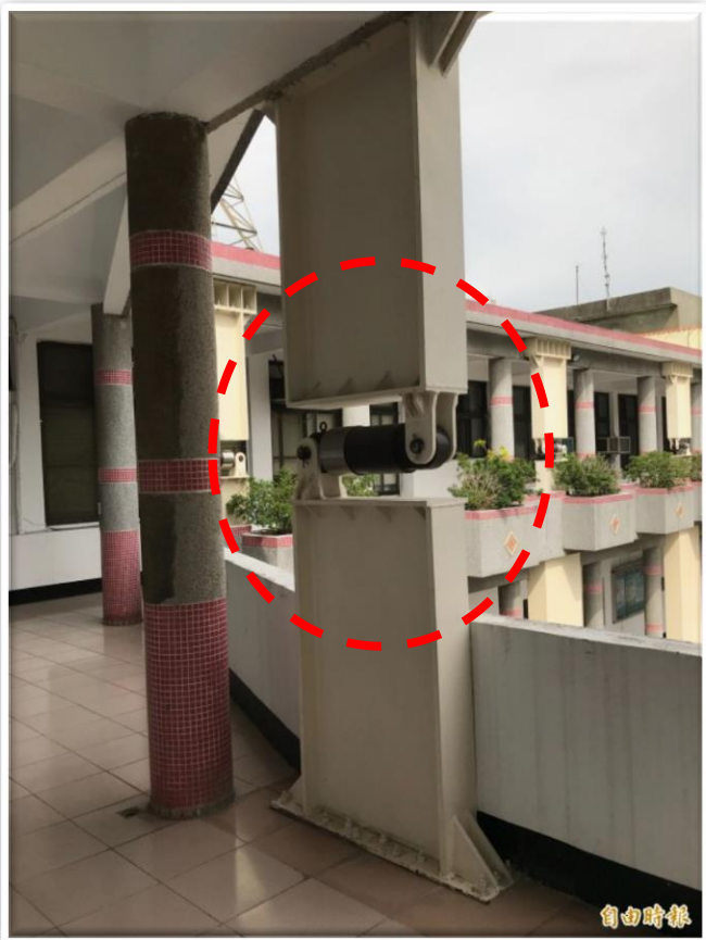
具在地特色 仁德公所耐震補強變裝置藝術
