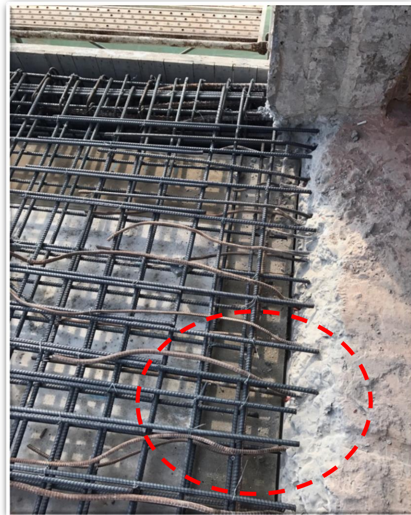
二F左棟廁所樓版於樓板綁鋼筋時將扭曲處切除
