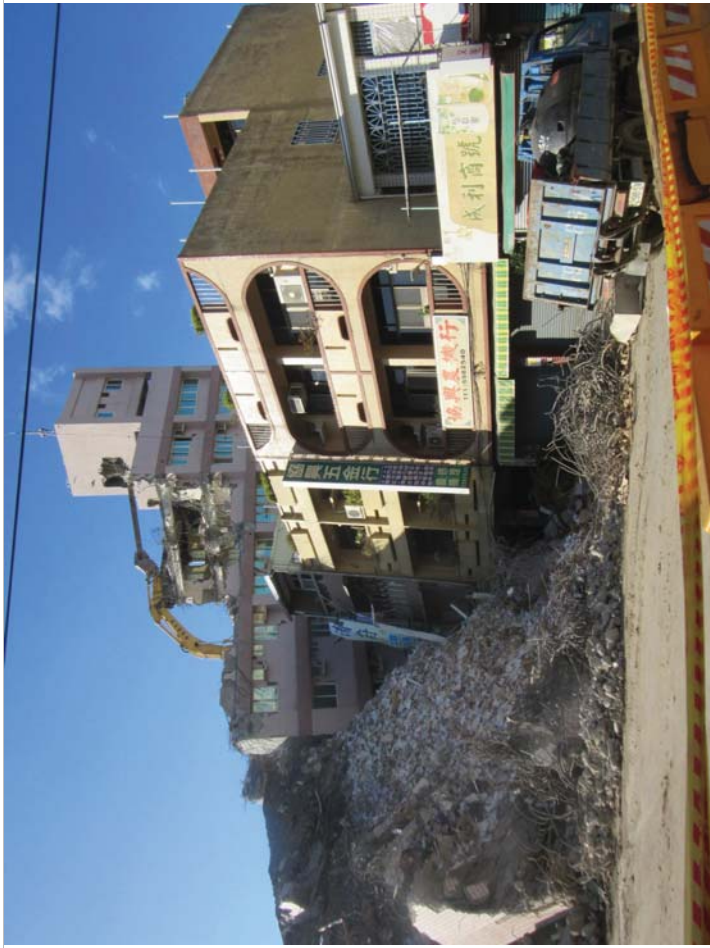
新化區中山路京城銀行傾斜並壓損鄰房，拆除中
