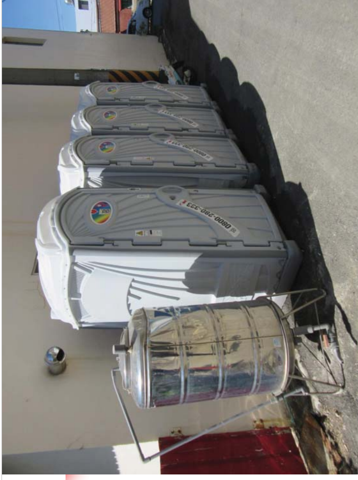
新市區三民街50巷液化，污水管拉斷廁所堵塞，必須使用臨時廁所
