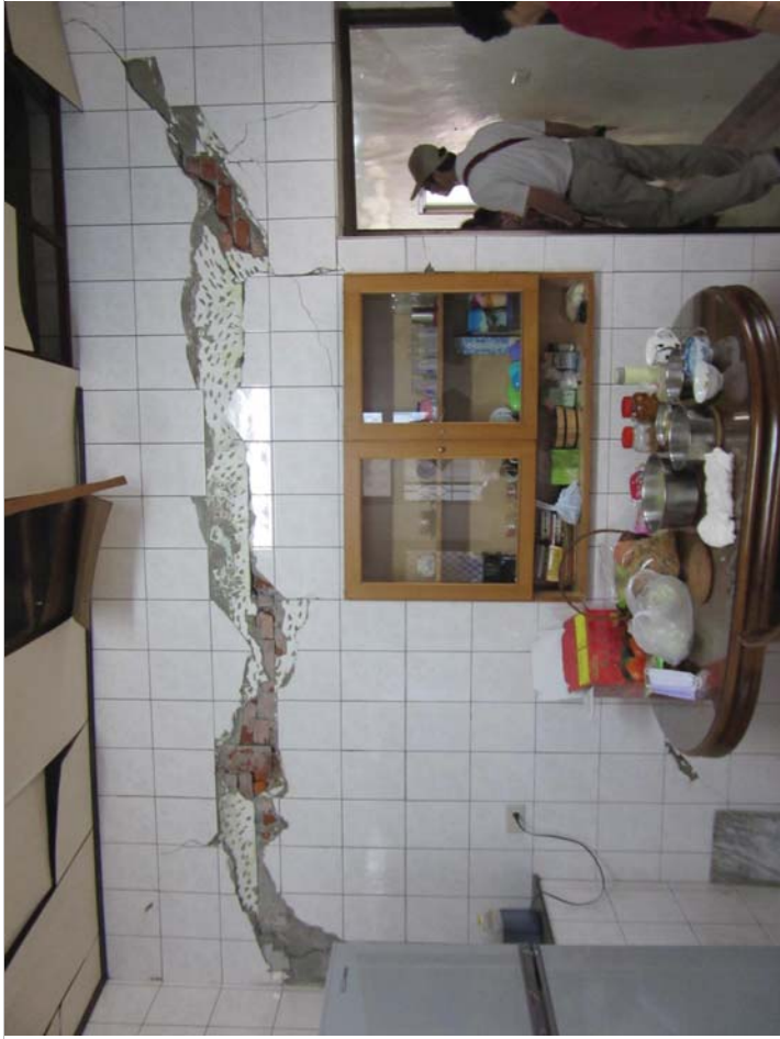
餐廳與廚房隔間牆破損
