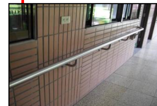
走廊設置扶手
