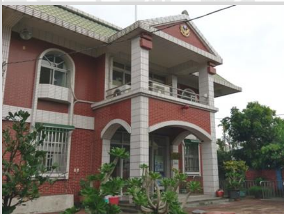
臺南市政府警察局 新營分局重溪派出所
