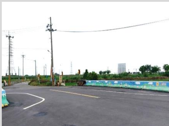
八老爺橋（橋下為八老爺排水）
