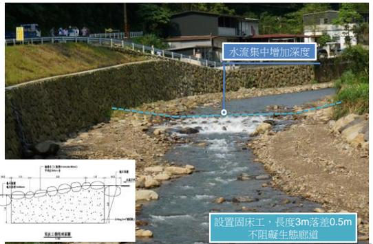
設置固床工，長度3m落差0.5m
