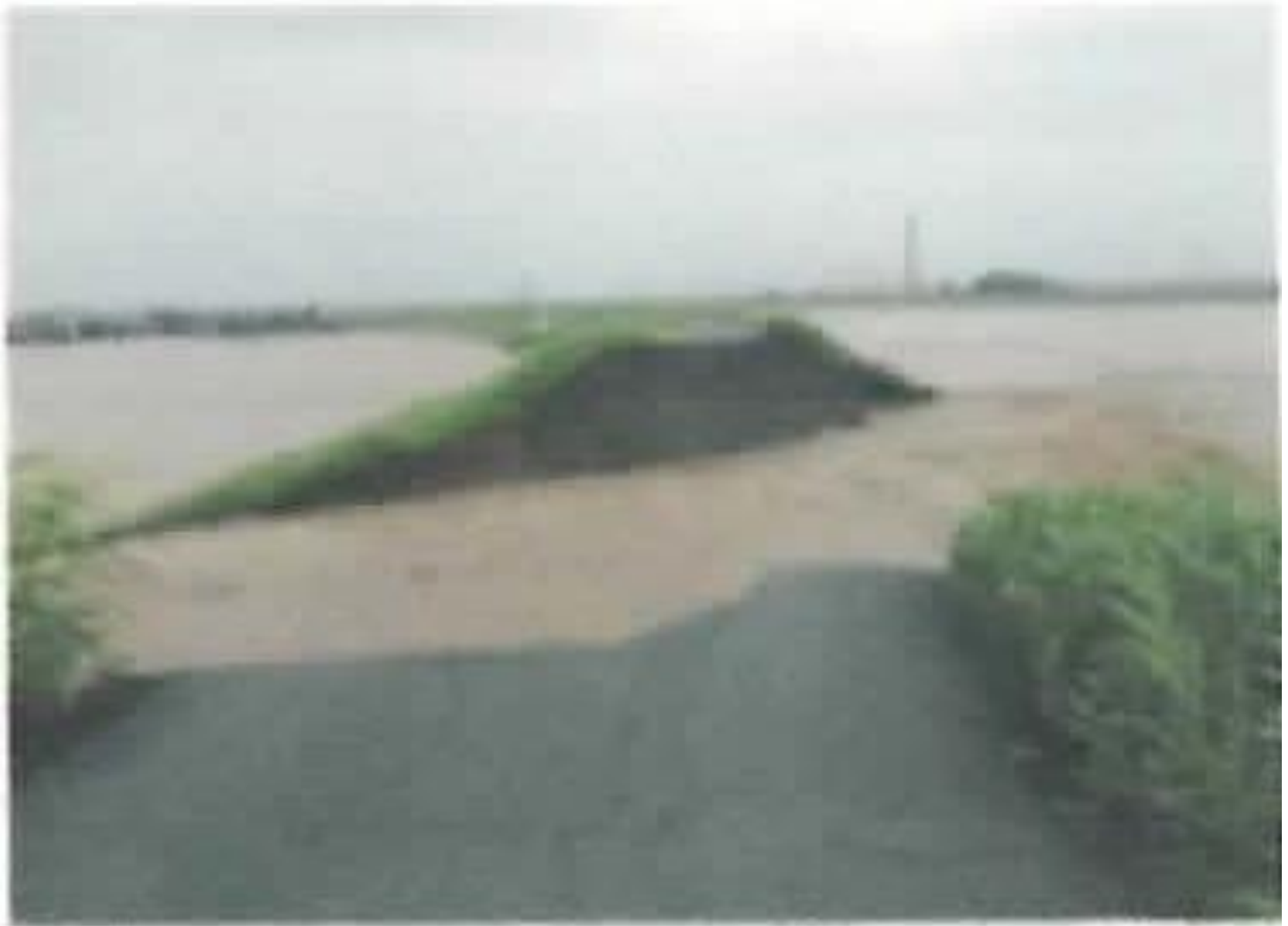
矢部川決壊箇所(越水なしに破堤) 2012年7月14日15:30頃
