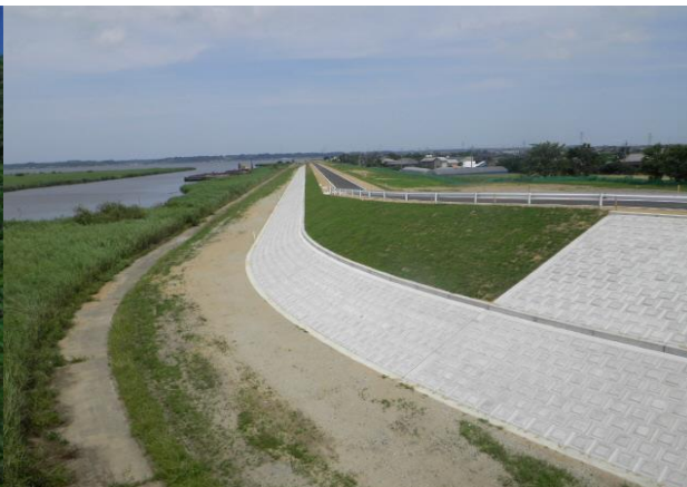
堤防の強化・嵩上げ
