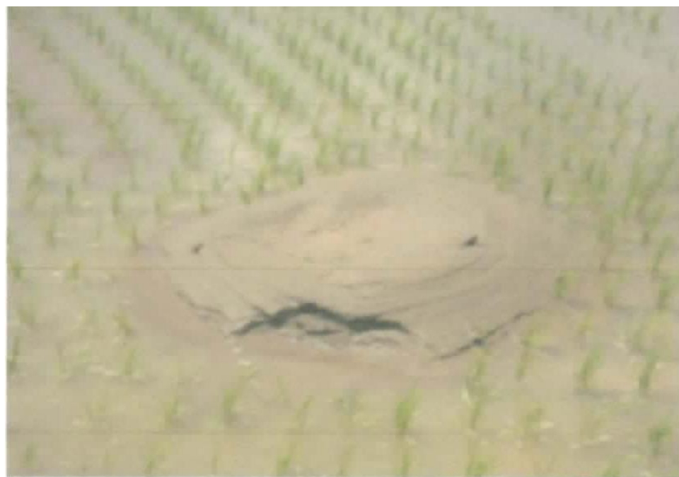
矢部川での堤内地における噴砂
