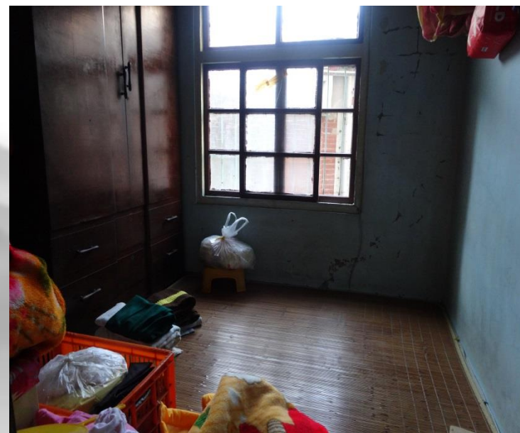
臥室牆壁斑駁、床板老舊
