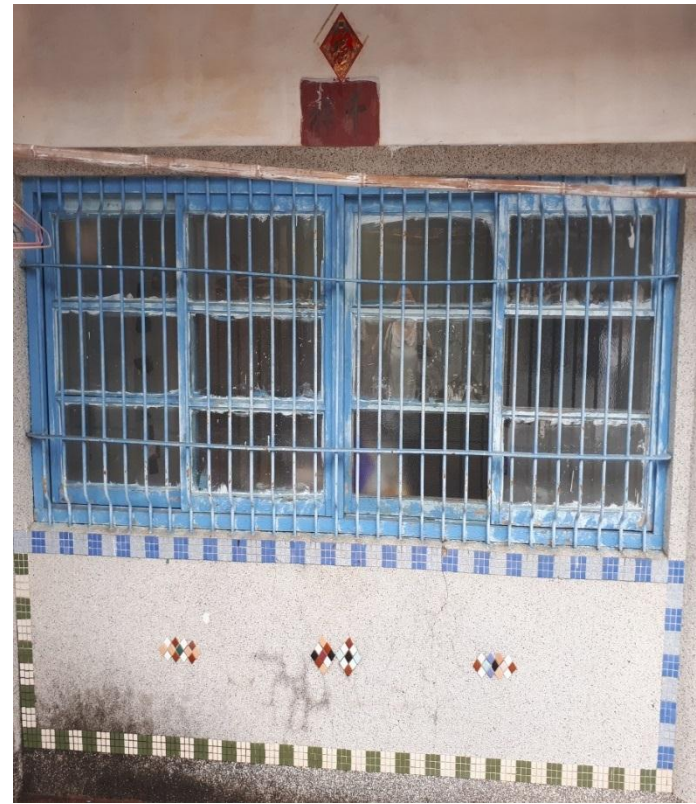
修繕後(側門玻璃)
