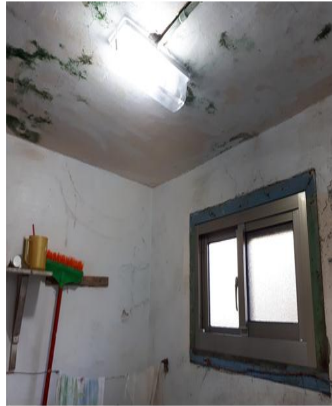
修繕後(廁所窗戶)
