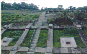
山坡地開挖採地錨穩定
