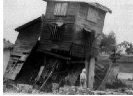
新化鎮木造榨油廠傾倒 (1946.12.23 攝，根據張麗旭等(1947))
