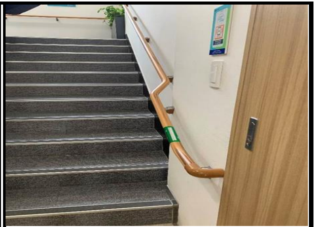
樓梯設置扶手，高度適中易於使用
