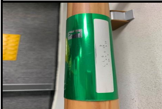
樓梯扶手上的點字設計，打造無障礙空間
