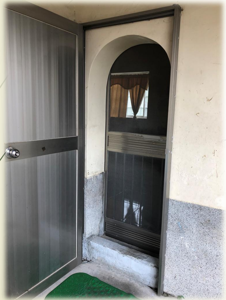
修繕前進出門
