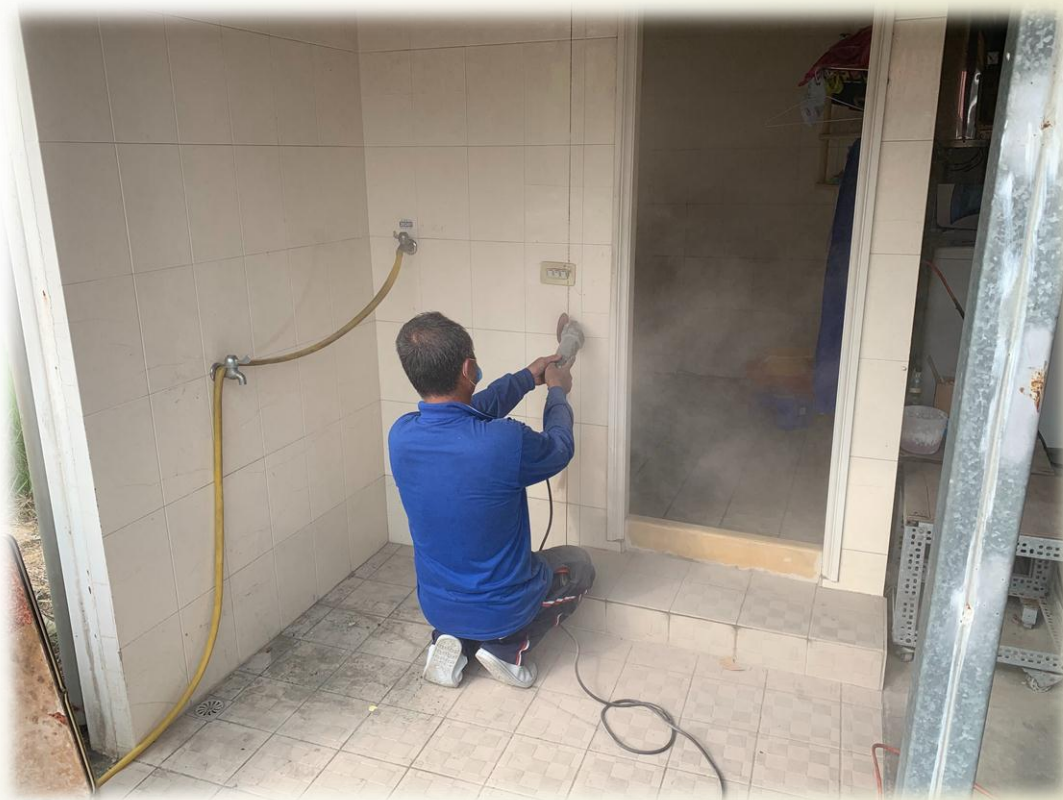
修繕前浴室門
