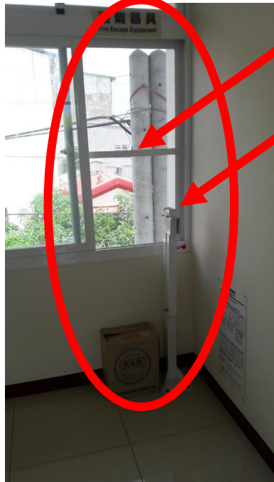
相片 11、二樓室內空間西北隅開窗設置之室內緩降機位置外部樹立電桿，緊急避難時有誤觸感電之虞，建議調至西南隅開窗處。
