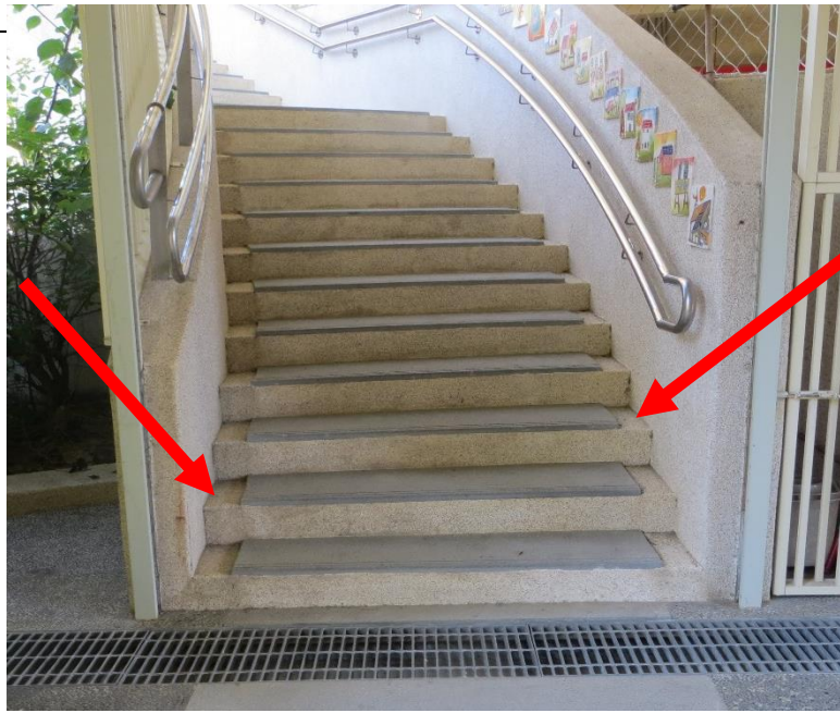
相片 9、設計建築師細部處理能力紮實到位，如：樓梯梯級兩端之排水路徑收邊處理，有助於減輕校方能整棟建築物之維護管理。
