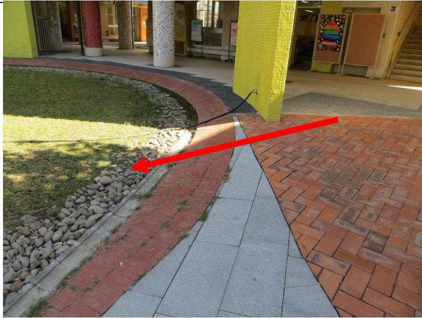
相片 25、地面排水溝鋪設卵礫石，避免垃圾掉入並防止蚊蟲孳生。
