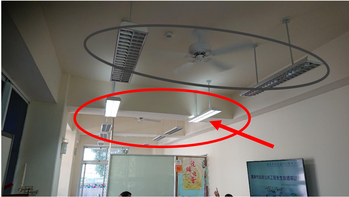
相片 11、2 樓會議室(簡報室)燈光控制系統採單切迴路，個別控制，可適應光度需求彈性控制。
