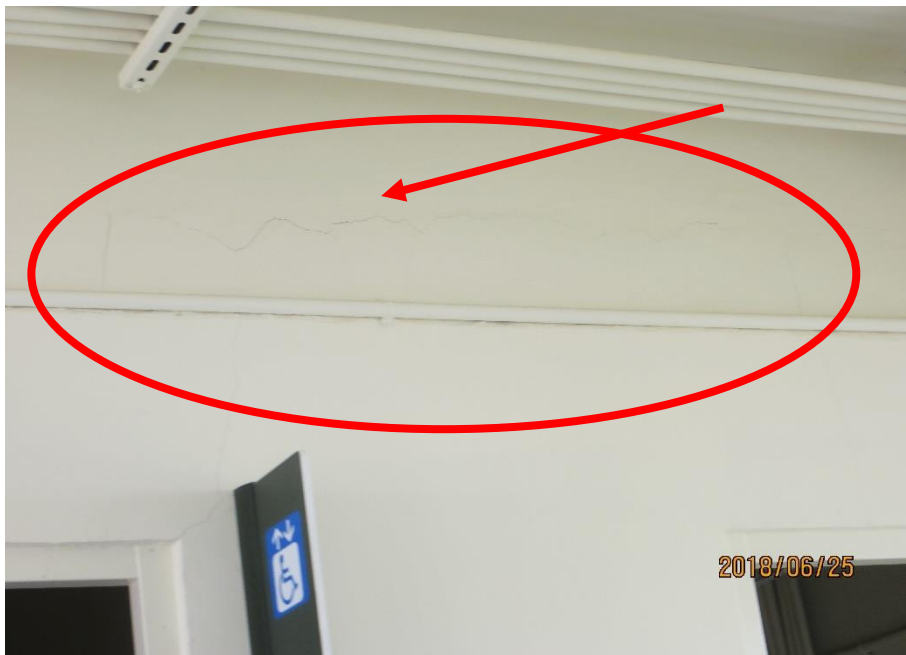
相片 19、二樓室內開窗隅角及昇降機間磚牆與 RC 梁接續面龜裂現象，建議補強。
