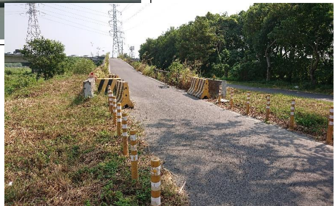
相片 6、跨河段橋梁南側之防汛道路路阻護欄塊遭移置。
