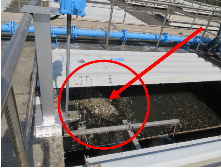
相片 1、除浮渣易堆積在刮除片旁之缺點外，尚有該設備之設計係將機械鍊條置於水中，易生鏽部且不易保養之缺點。
