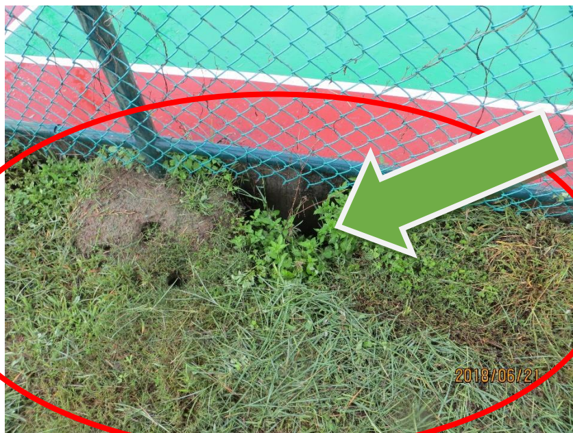
相片 5、球場邊土壤下陷，應先警示並查明原因再予回填，避免人員跌落。
