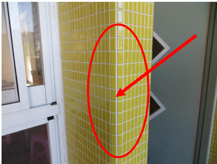
相片 7、設計建築師細部處理能力紮實到位，如：牆或柱隅角部之鈍角防撞處理，有助於減輕校方能整棟建築物之維護管理作業。
