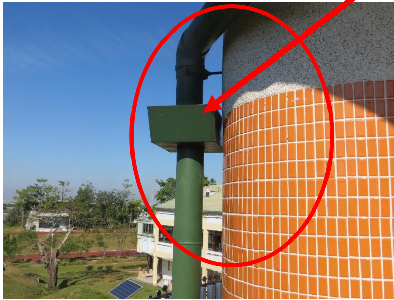
相片 5、設計建築師細部處理能力紮實到位，如：落水管檢修接水斗(走廊內之接水斗因有被碰撞之虞，故設置位置較高，但可使用 A 字梯觀察及清除斗內雜物)，有助於減輕校方能整棟建築物之維護管理作業。
