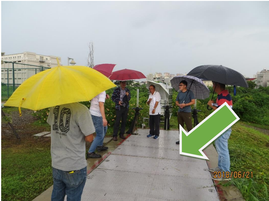
相片 3、巴歇爾量水槽宜設置透明框蓋視窗以利檢視（目前水槽上方以鍍鋅蓋板覆蓋，如需觀測則須掀蓋，較不方便）。
