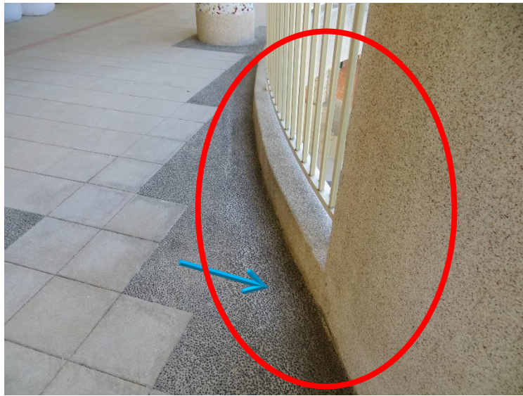
相片 3、設計建築師細部處理能力紮實到位，如：走廊邊溝順滑處理(利於風雨侵入時地板洩水且較矩形凹溝安全，不易因邊溝高度落差而跌倒)，有助於減輕校方能整棟建築物之維護管理作業。
