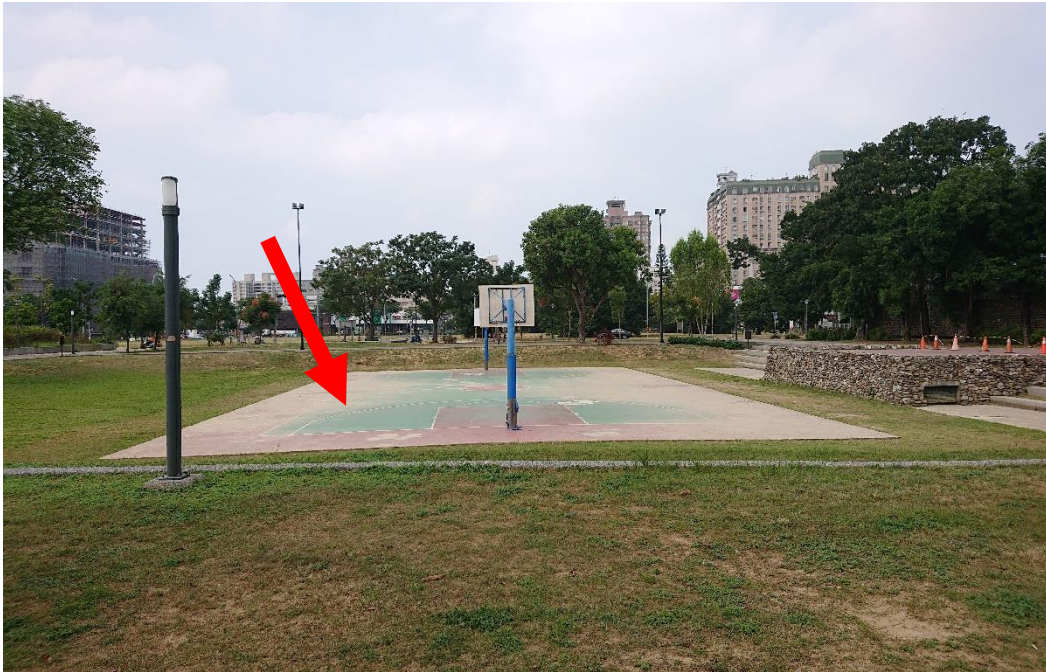
相片 11、滯洪池因考量生態而將底部設計為滲透式，但後續又於滯洪池底部設置水泥地面作為籃球場，其理念與作法似有矛盾。
