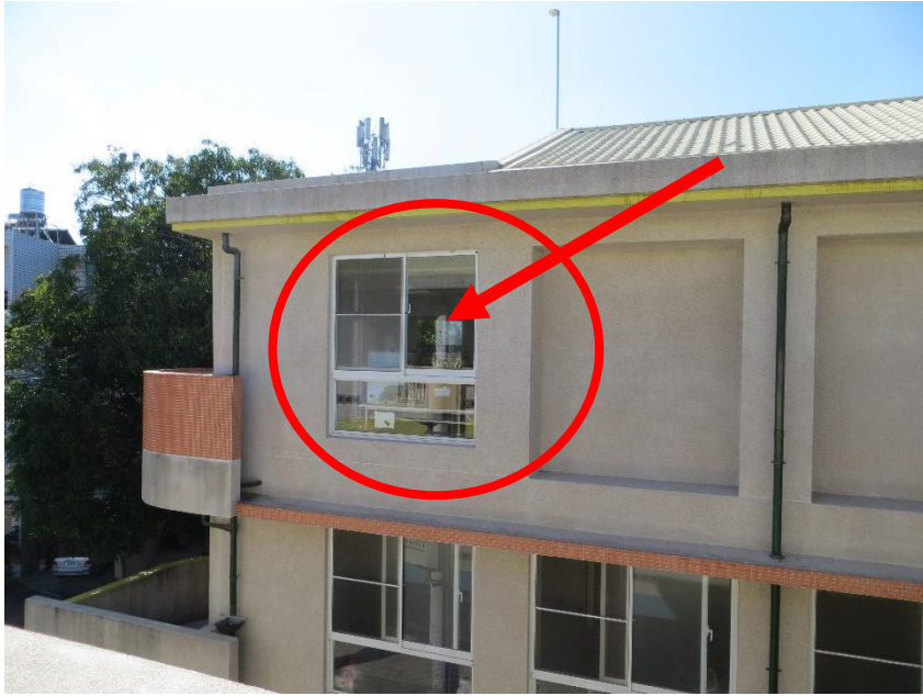
相片 21、強化玻璃爆裂現象，起因於日曝，無可避免，以貼膜方式因應，應有助於減緩強化玻璃爆裂現象。
