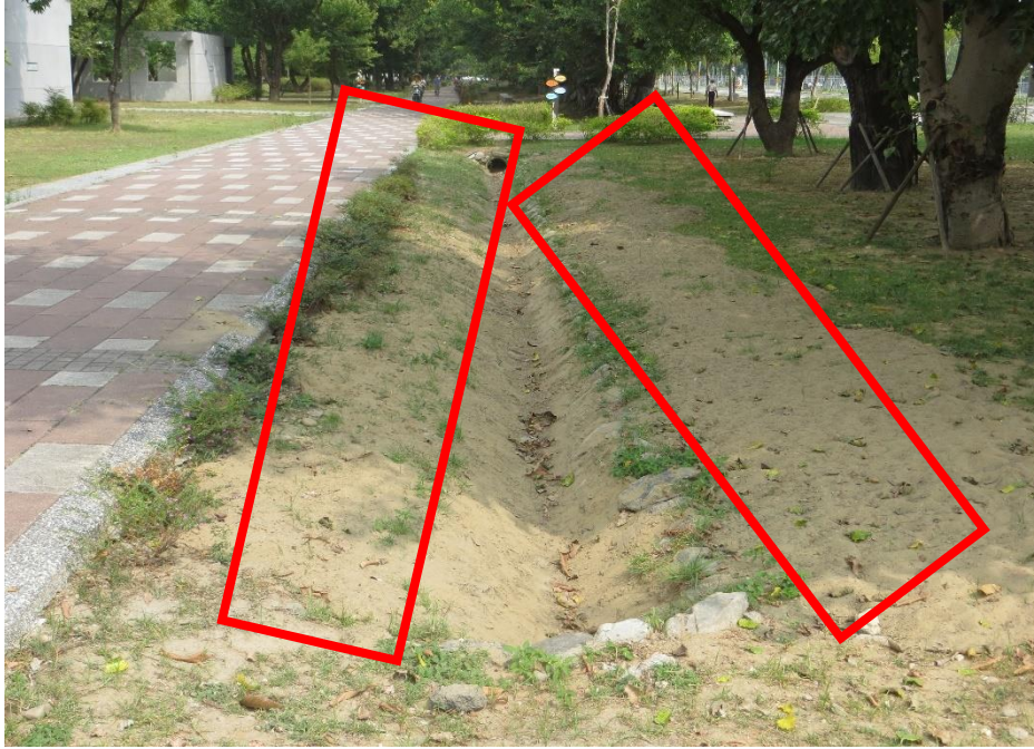
相片 9、草溝清淤之淤土宜清除，勿就近堆置，不僅易因雨水沖刷回流草溝，且妨礙草皮生長亦有風沙飛揚之虞。
