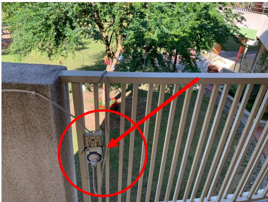
相片 19、臨時架設之電源插座建議採用防雨型且應固定牢靠。
