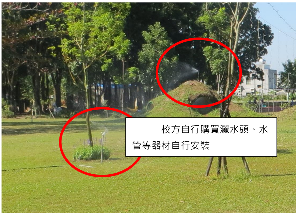
相片 26、天地下室地面水集中導入筏基，枯水期抽出，提供校園植栽草皮自設之噴灌系統用水。
