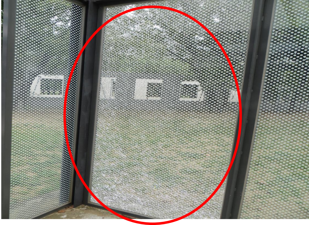
相片 5、棚架下方已破裂之隔間玻璃宜考量其未來用途，而可加膠膜加強防護或完全去除。
