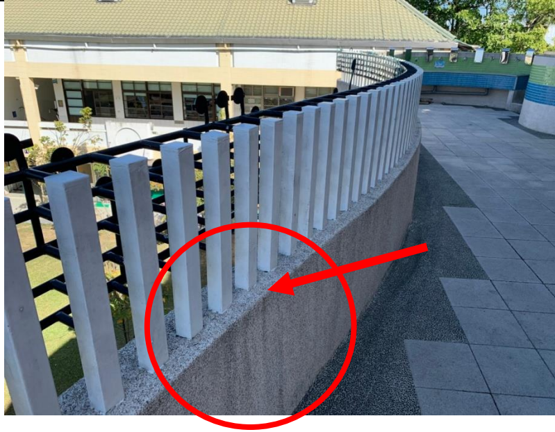
相片 13、二、三樓走廊兩截式攔干(下方為實牆,上方為格柵條)設計,格柵方管與實牆剩餘之頂面易成攀爬行為之墊腳石,建議實牆頂面走廊側之空擋處加設斜板,可避免墜跌事件。
