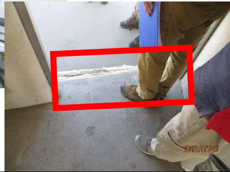
相片 1、屋頂突出物防火門缺人造石門檻，以防止風雨進水。
