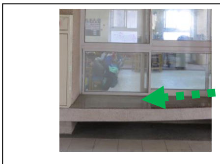
相片 22、樓梯間露梁頂部及弧梯背面抵石座椅台頂面均易蓄積灰塵，不利清掃，建議加蓋亮面石板(如：窗台之亮面石板)因應，有利於清掃，及提昇憩座意願。
