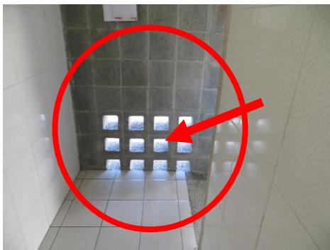
相片 4、設計建築師細部處理能力紮實到位，如：廁所空間之上下通風路徑之除臭除濕功能，有助於減輕校方能整棟建築物之維護管理作業。
