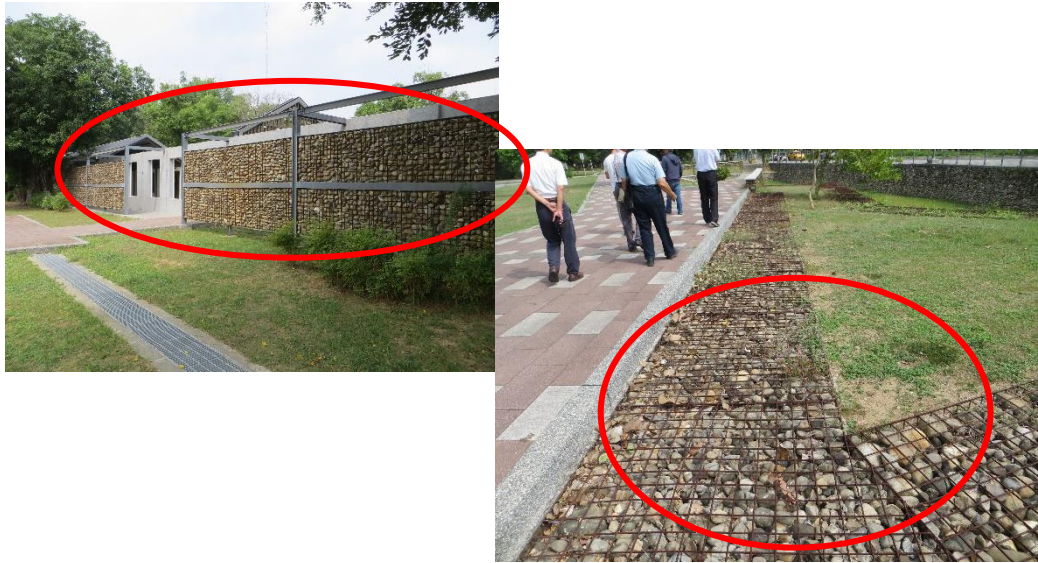
相片 13、作為高牆體點銲鋼絲網箱籠，鏽蝕明顯而有安全之虞；然作為生態滯洪池駁坎之點銲鋼絲網箱籠，除因鐵絲鏽蝕而有崩塌狀況外，頂面落葉亦難清除且若小孩踩踏，其腳掌有陷落鋼絲網網孔之虞，除宜隨時注意及改善外，日後設計亦應考慮使用全及易於維護。
