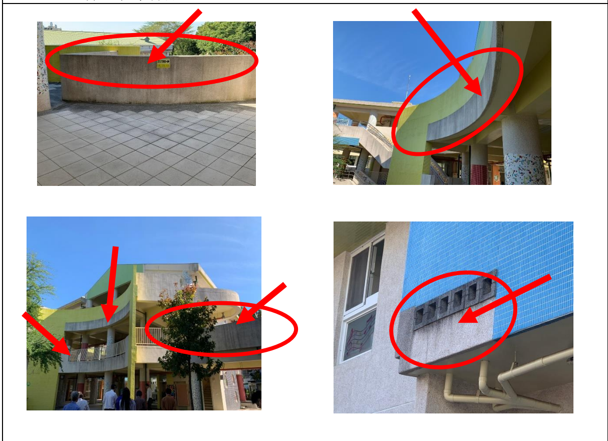
相片 18、抵石子牆面污漬現象均因未設置滴水條、及滴水勾縫深度不足引發，建議於抵石子頂面加設滴水條，應有助於抵石子牆面污漬現象持續發生。
