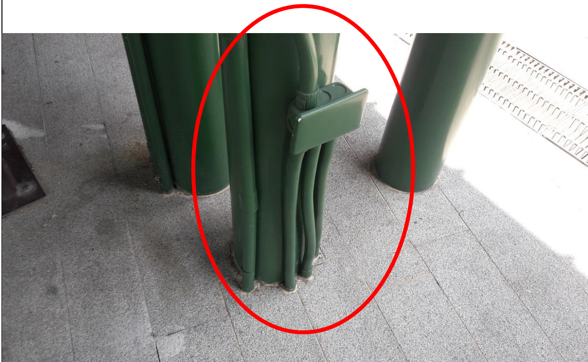
相片 11、二樓室內空間西北隅開窗設置之室內緩降機位置外部樹立電桿，緊急避難時有誤觸感電之虞，建議調至西南隅開窗處。
