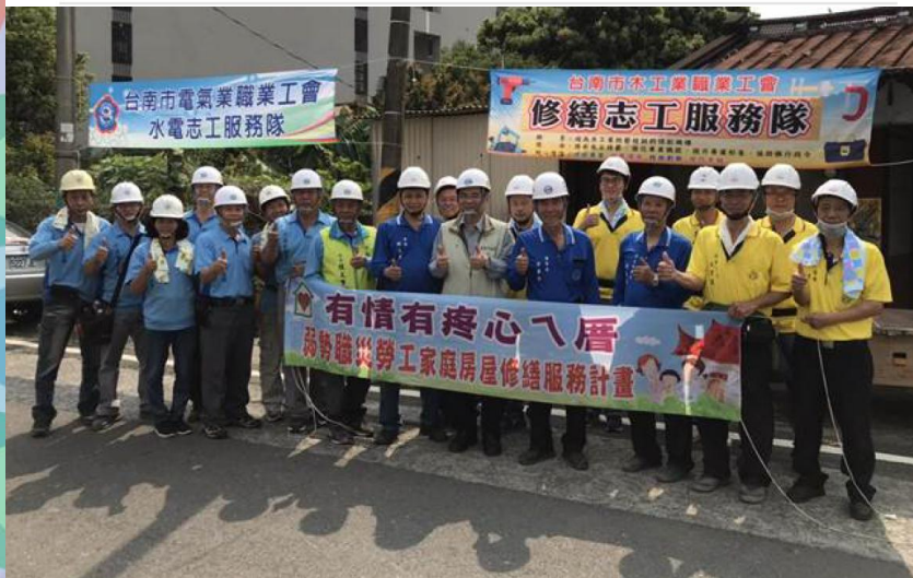
台南市勞工局修繕志工22日前往善化區幫民眾修屋。(台南市勞工局提供 / 劉秀芬台南傳真)
