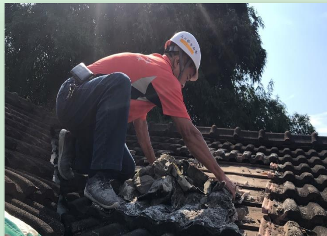
破損屋瓦汰換作業
