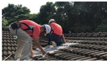
泥水工職業工會修繕志工頂著烈日在大內換新屋瓦。記者謝建盛/翻攝台南市政府勞工局長期結合各工會修繕志工為弱勢修屋，今兵分四路前往台南新營、大內、高雄市大樹區及嘉義縣梅山鄉同步進行修繕工作，邀請各界一起來關懷周遭弱勢勞工。
