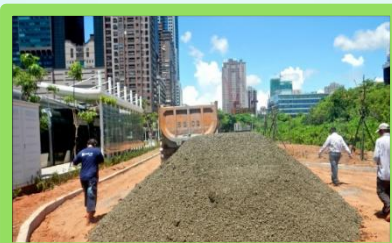
鋪面工程級配粒料基底層 (道路、人行道、貨櫃場、停車場)
