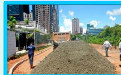
道路工程級配粒料 基底層
