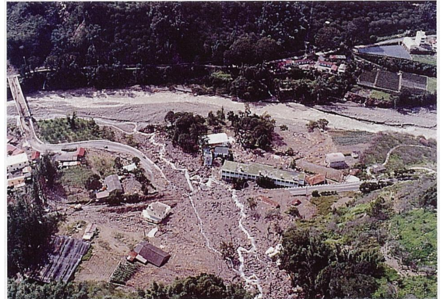
▲土石流堆積在坑溝出口平緩地帶成沖積扇 (南投縣信義鄉神木村隆華國小附近)
