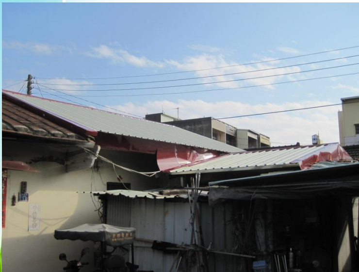
臥室區屋頂完成
