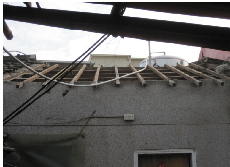
浴廁區屋頂拆除
