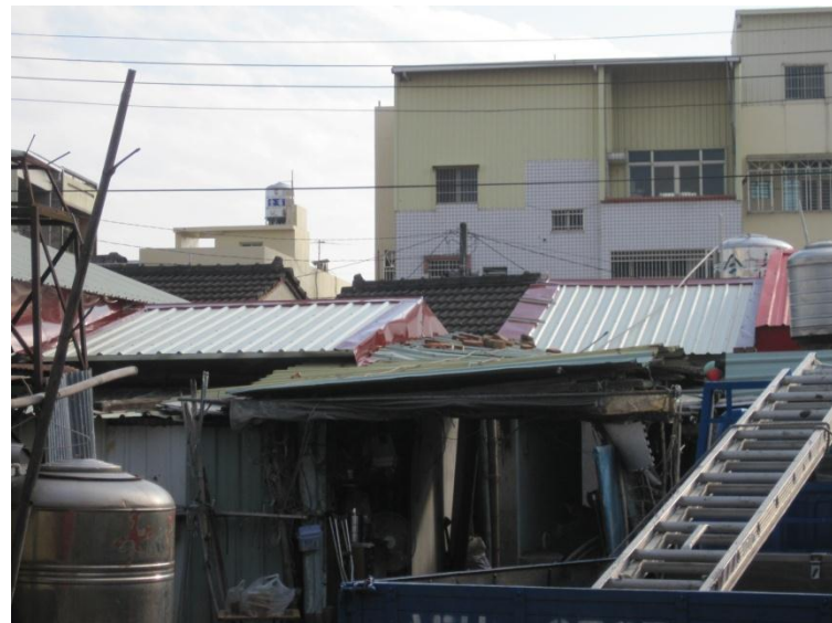
浴廁區屋頂完成
