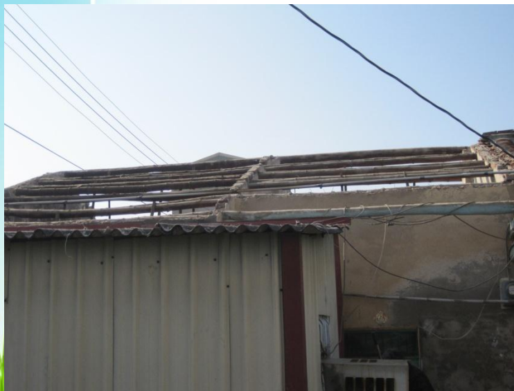
臥室區屋頂拆除
