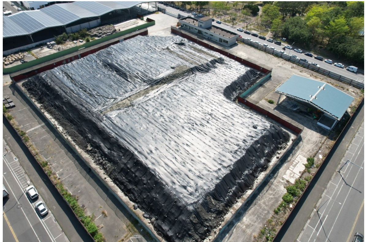
堆置區位置：臺南市安平區金華段 128 地號
