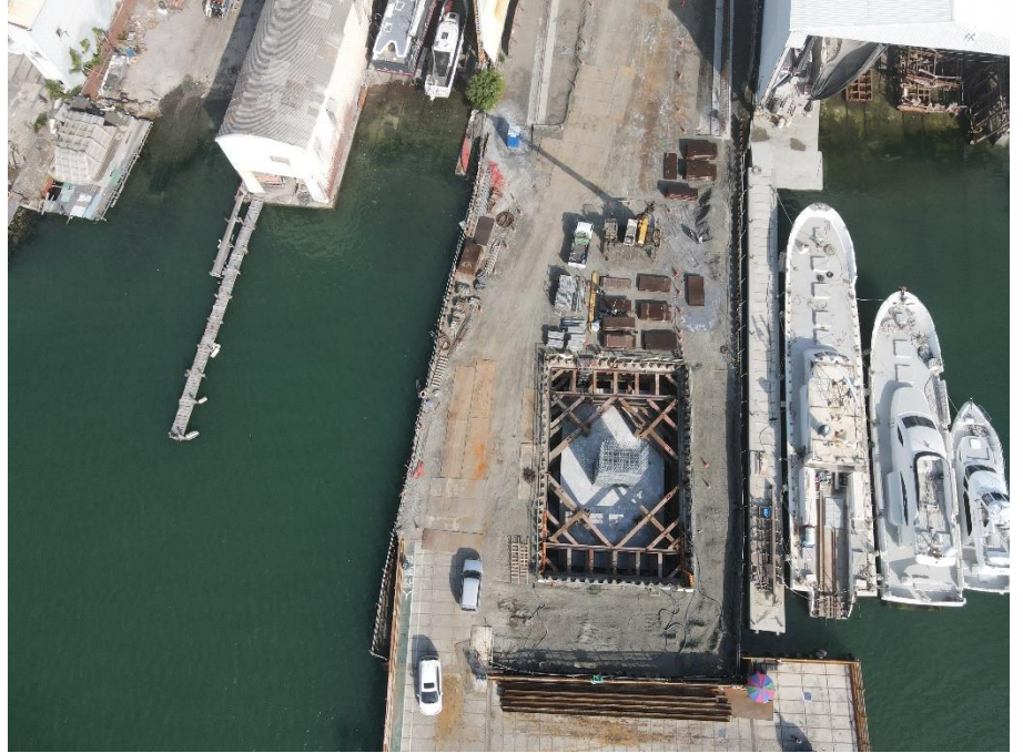
P7 橋墩基礎施作
