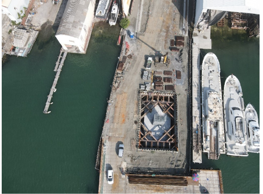
P7 橋墩基礎施作
