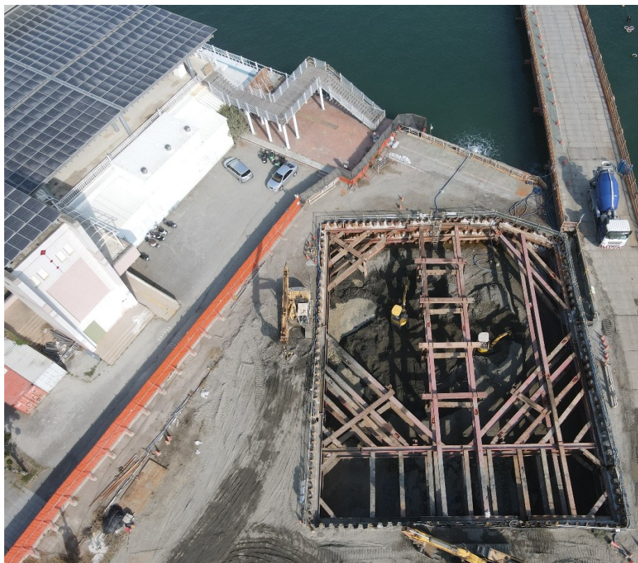
P3 橋墩基礎開挖及擋土支撐施作
