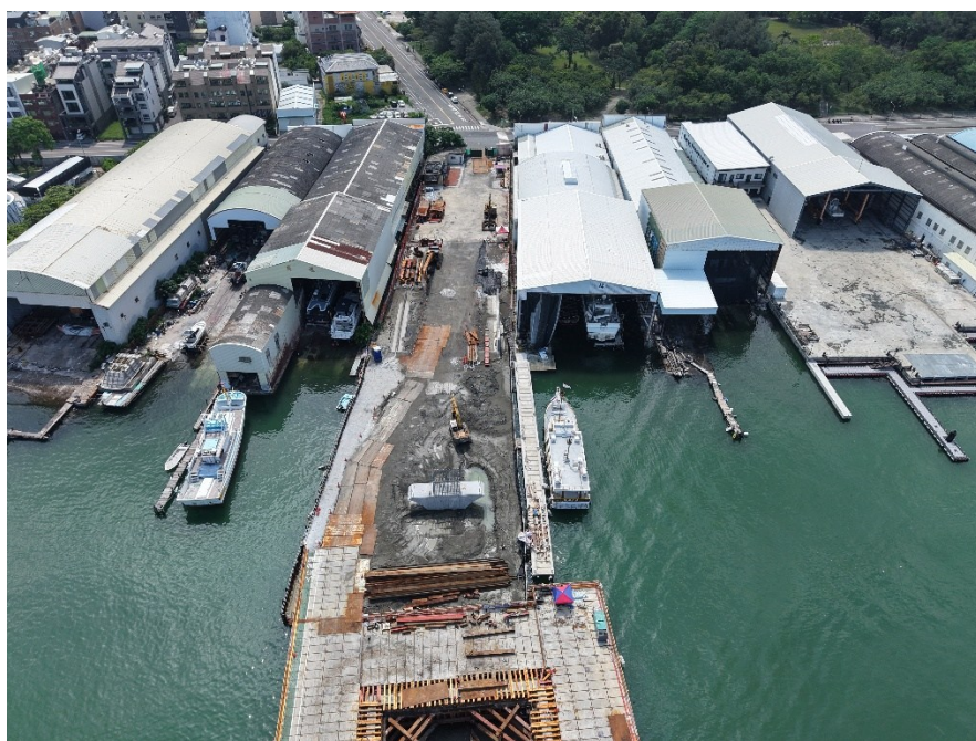
P7 墩基礎施作
