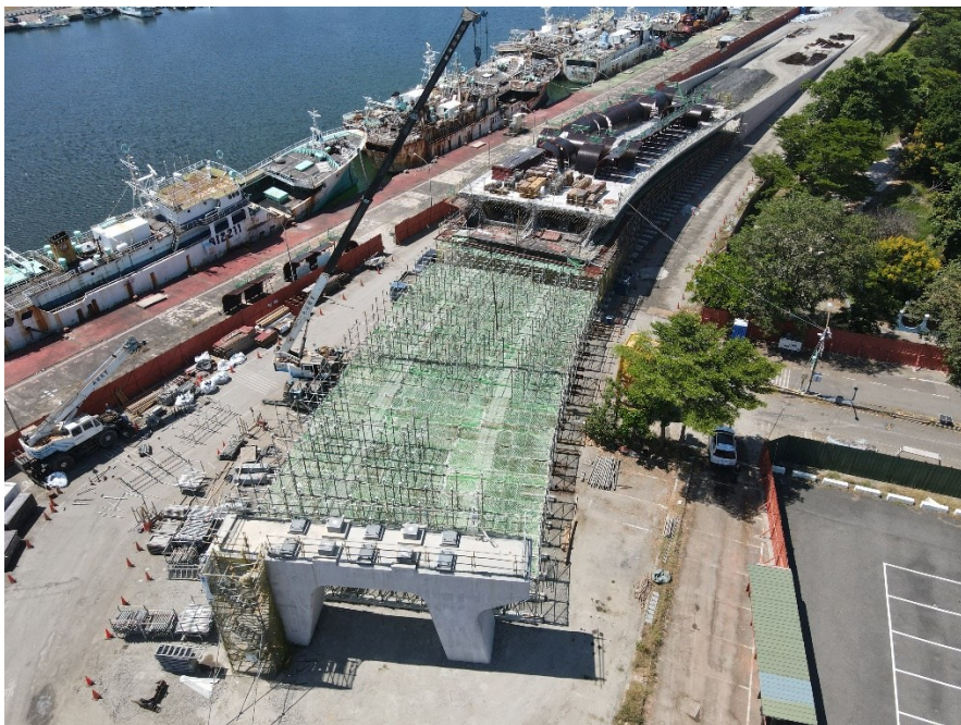
U1 第二單元施工架組搭
