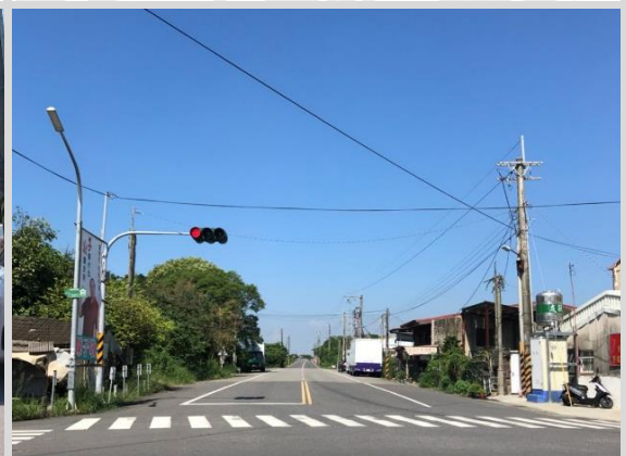
北勢洲橋（舊橋）延伸入庄路以南 （石城與石湖交界）
