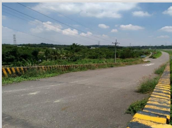
鄰曾文溪畔之內郭防汛道路
