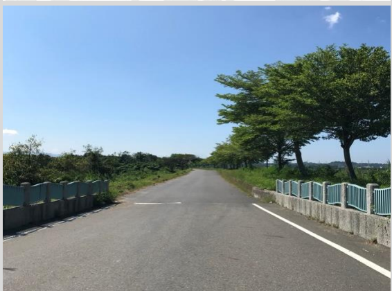
內江邊界防汛道路
