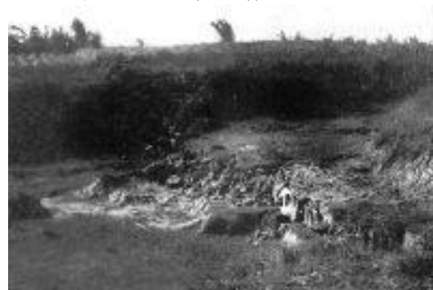
新化地震斷層露頭—新化鎮思橋(深坑橋)北側公路(中山路，台 20 號公路) (1946.12.27 攝，陳培源教授提供)。
