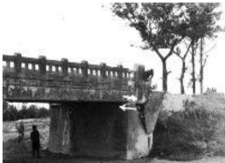
新化鎮大目降橋(大目橋，中正路，177 號縣道上)之南端橋身向西錯移 26.5 公分 (1946.12.27 攝，陳培源教授提供)
