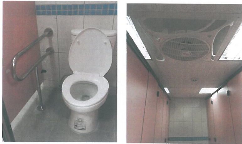
圖5：玉井市場（一字型扶手、輕鋼架循環扇T-bar 燈、偵煙器）
