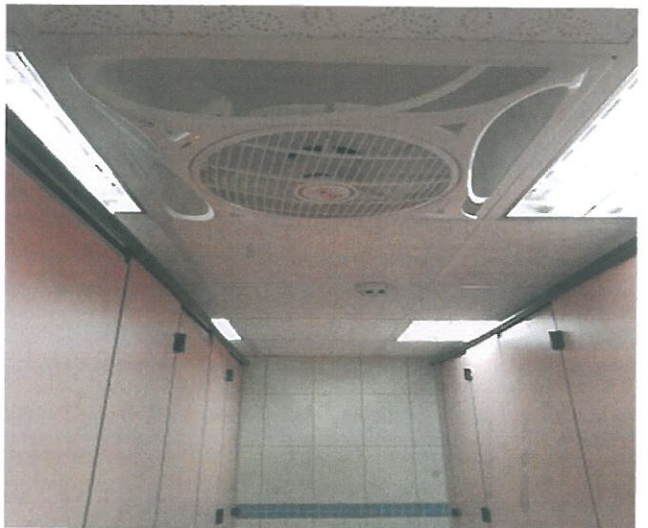
玉井市場（一字型扶手、輕鋼架循環扇 T-bar 燈、偵煙器）
