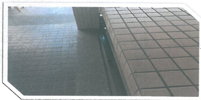
圖 4：山上市場（地板整修+不鏽鋼水溝）
