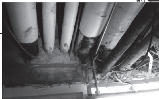
直接以水泥封填
