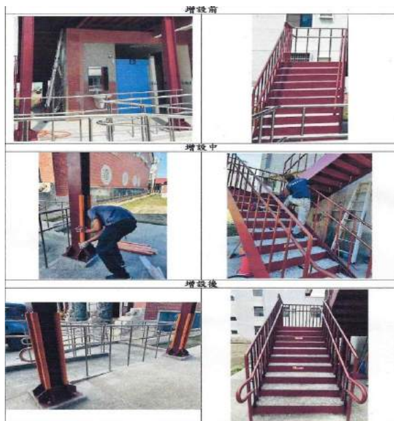
大吉里辦公處大屯活動中心增設樓梯扶手及PU防護條
