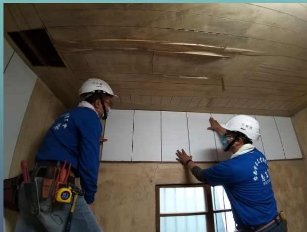
安裝牆壁美化板
