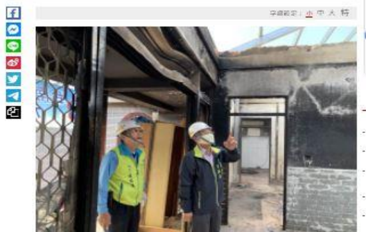
做工善團志工與義工們正在玉井區玉井里一戶火災戶修屋頂，趕在農曆年前完成修繕工作。(台南勞工局提供)
