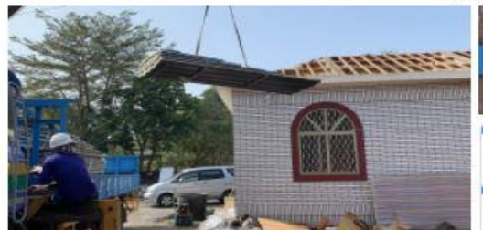
做工善團志工與義工們正在玉井區玉井里一戶火災戶修屋頂，趕在農曆年前完成修繕工作。(台南勞工局提供)
