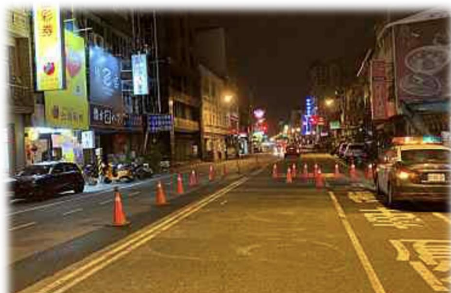
日前安中路一段兩側施工完成後，同時佈設交維，造成用路人受傷請求國賠
