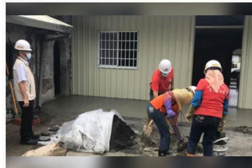
南市做工行善團把握天氣放晴，趕工為4戶弱勢家庭修繕房屋。圖/台南市政府勞工局提供
