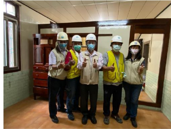
勞工局做工行善團志工假日房屋修繕，勞工局長王鑫基(左三)為志工夥伴加油打氣。(勞工局提供)
