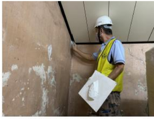
▲行善團假日不休息讓南區南鯤鯓60歲施姓職災勞工能夠好好的安心居住(記者黃雋淮南翻攝照片)
