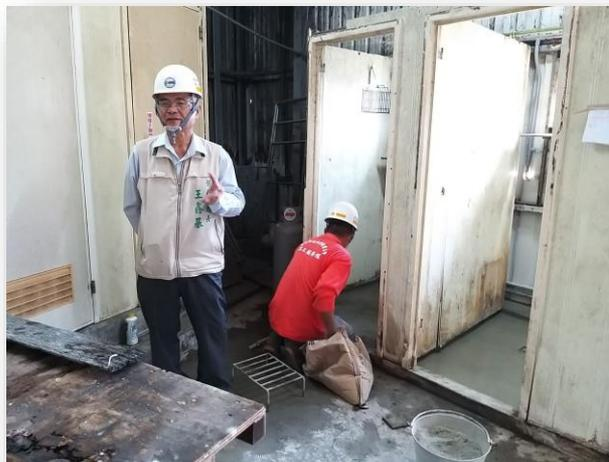
廚房磚塊填高修補施工(泥水)
