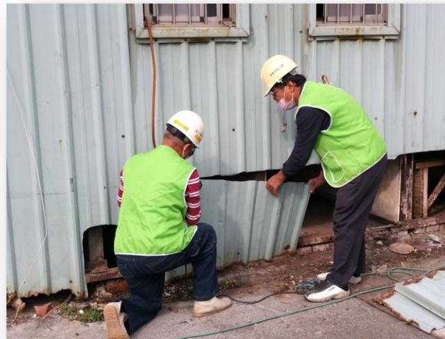
外牆鋼板加強補修施工(金屬)
